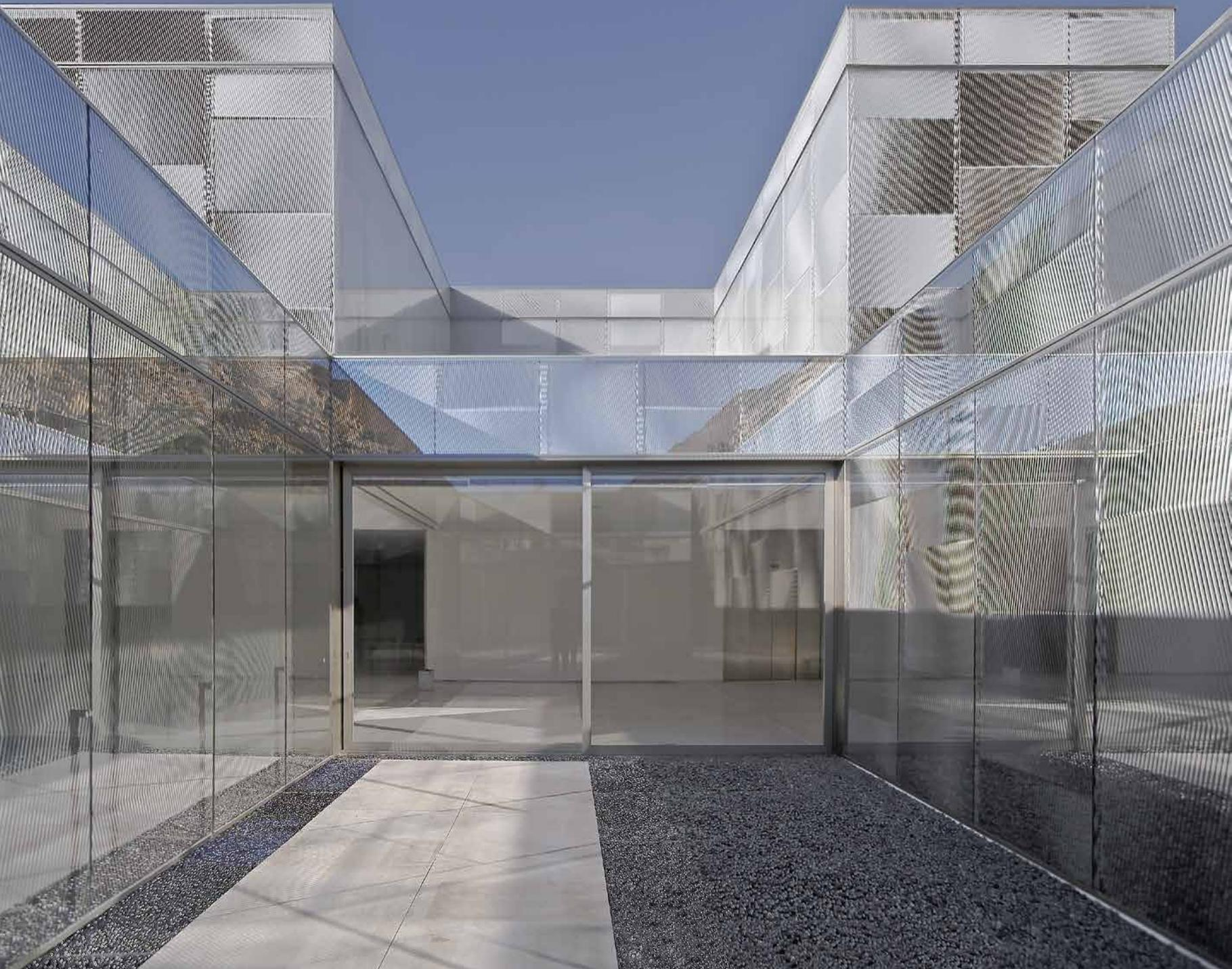
Para las fachadas se ha utilizado el sistema de muro cortina GEODE.
