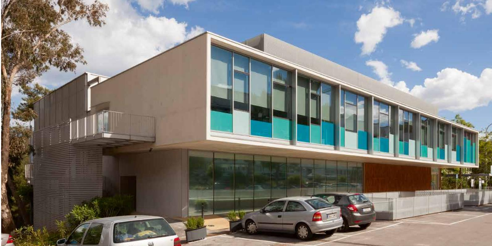
Se ha utilizado el sistema de muro cortina GEODE, logrando así prolongar visualmente la fachada del edificio.
